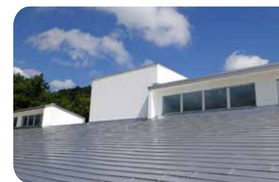
大信小屋上防水施工後
