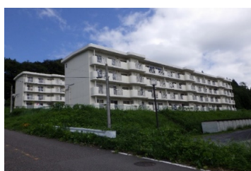
石久保市営住宅
