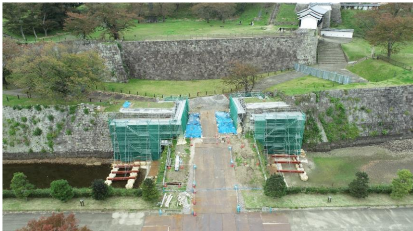
【復元工事が進む清水門(南から)】
