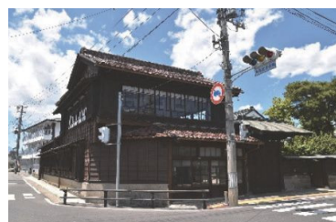
藤屋建造物群
