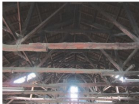
作業所のトラス構造の二重梁
