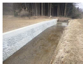
改修した護岸
