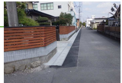
側溝改修状況
