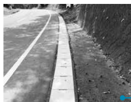
改修された側溝
