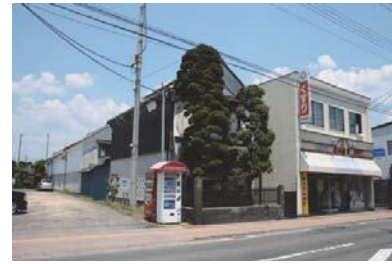
松井薬局建造物群
