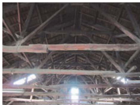
作業所のトラス構造の二重梁
