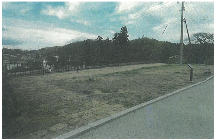
▲矢之門張芝・柵設置状況
