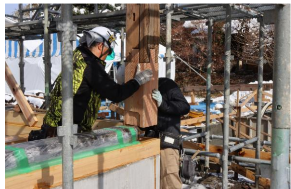
▲施工中(根継ぎした柱を立てる様子)
