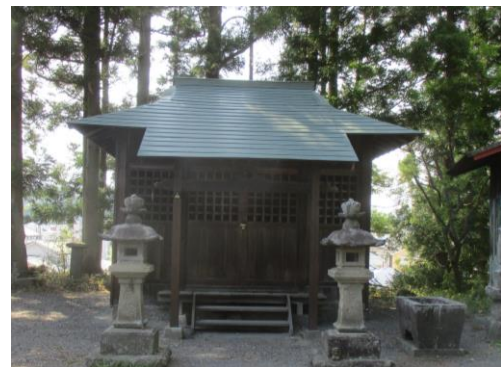
▲ 秋葉神社 壁・屋根復旧状況
