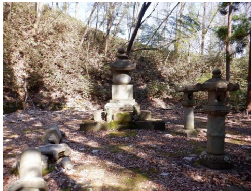
▲ 白河藩大名家墓所 五輪塔・灯籠破損状況
