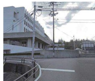
④ 廃道予定箇所 東側から
