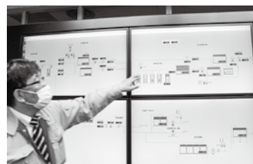
配水の状況はモニターで監視（立石山配水場）
