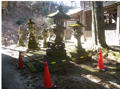
▲境の明神 灯籠破損状況
