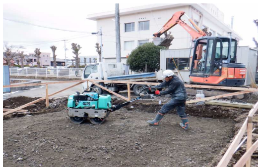
▲基礎工事の様子
