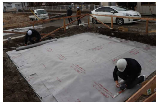
▲ジオテキスタイル(地盤補強シート)敷設の様子
