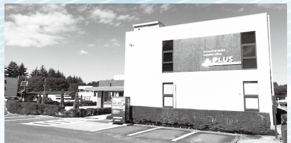
10月26日オープンした 「ラ・クリエーションプラス」
