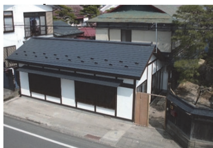
会津屋建造物群
