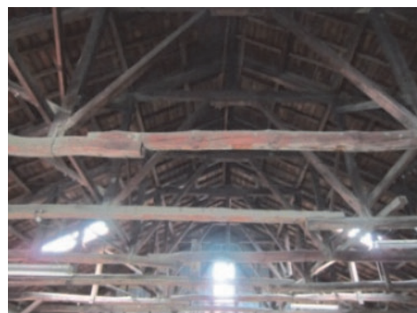
作業所のトラス構造の二重梁
