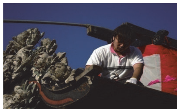
屋台の屋根組み立て準備
