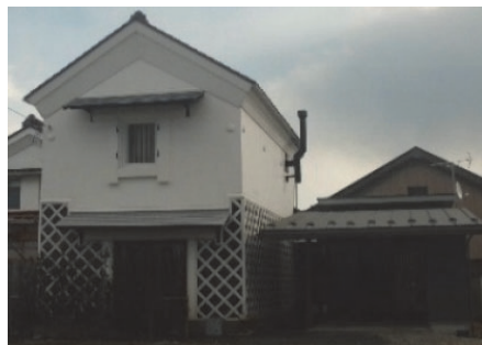
河和家住宅建造物
