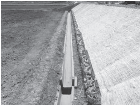
〈災害復旧現場〉
