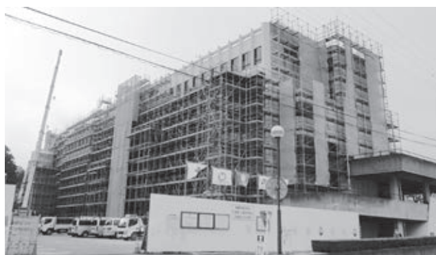
〈本庁舎耐震補強及び大規模改修建築工事〉
