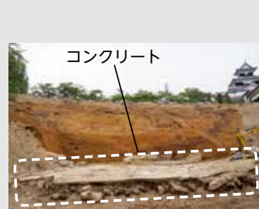
石垣裏側のコンクリート
