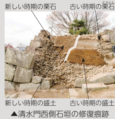
▲清水門西側石垣の修復痕跡
