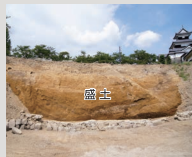
▲本丸南面石垣の裏側(南から)
