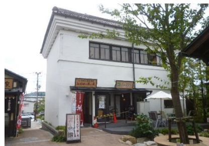
旧商工会議所建造物(中町)
