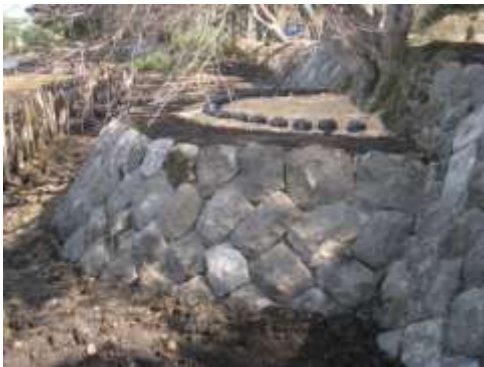
史跡及び名勝南湖公園の護岸整備
