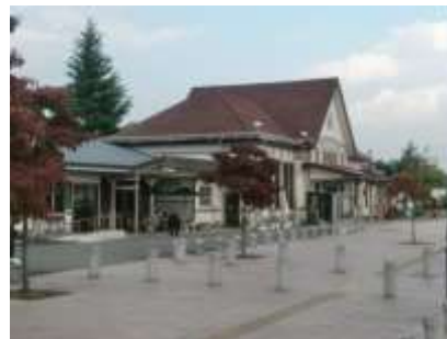
大正建築の白河駅舎(旧三の丸所在)
