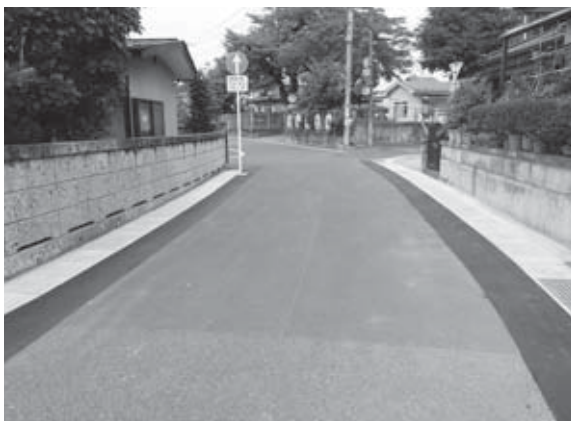
(道路・側溝改修後)
