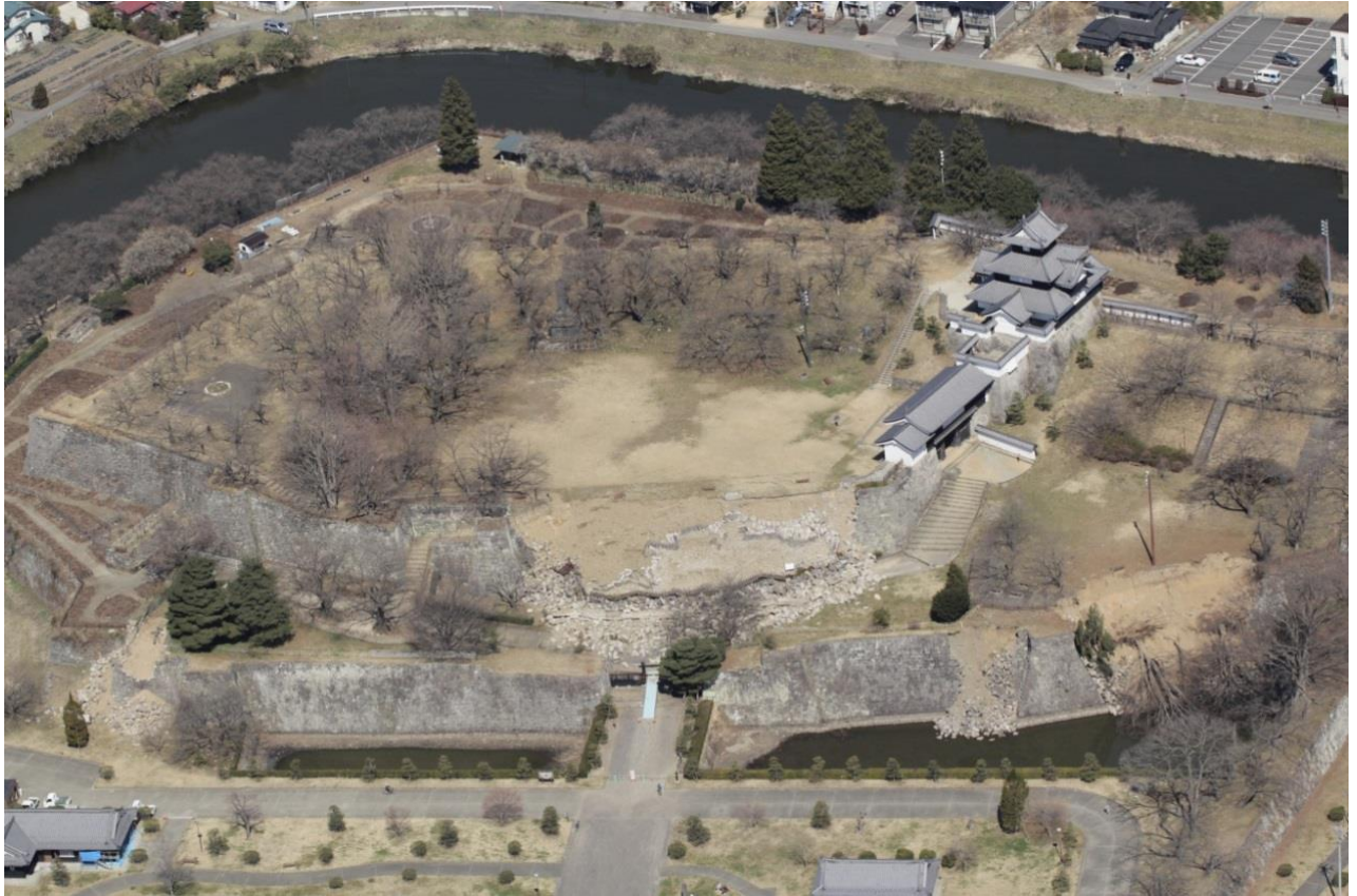
本丸周辺の被災状況（上空南から）
