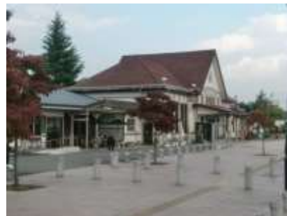
大正建築の白河駅舎(旧三の丸所在)
