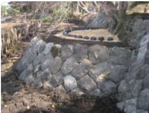
史跡及び名勝南湖公園の護岸整備
