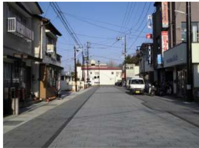
整備後(石畳による舗装)
