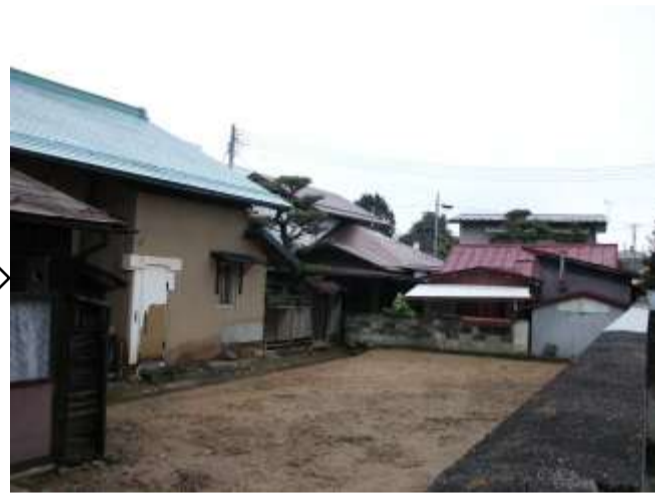
解体後(写真左が蔵座敷)
