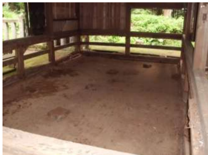
床板・大引・根太撤去 完了
