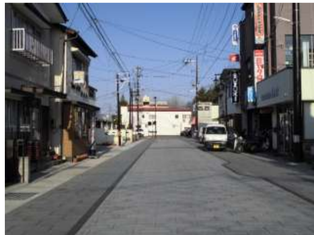
整備後(石畳による舗装)
