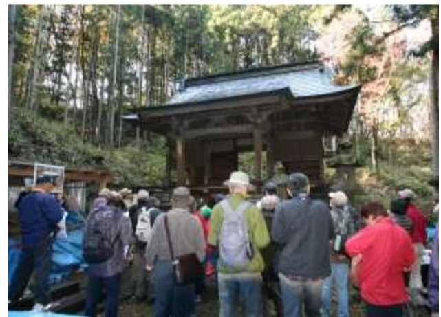
修復工事中の丹羽長重廟を見学 (平成25年11月16日:25名参加)
