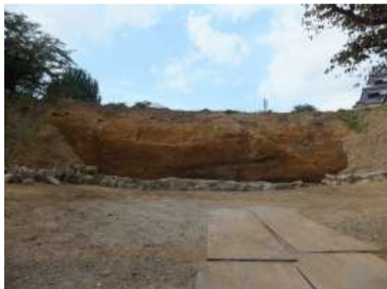
石材撤去後の本丸南面
