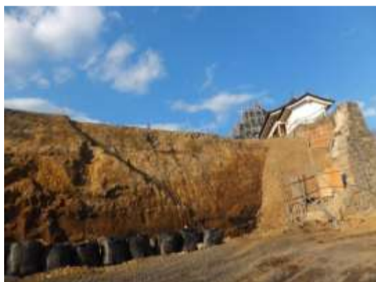
一部石垣を解体した東側部分
