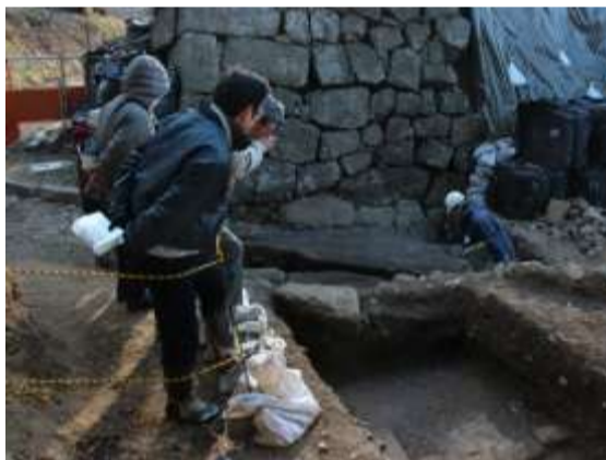
小峰城跡石垣修復箇所の一般公開 (平成26年1月19日)
