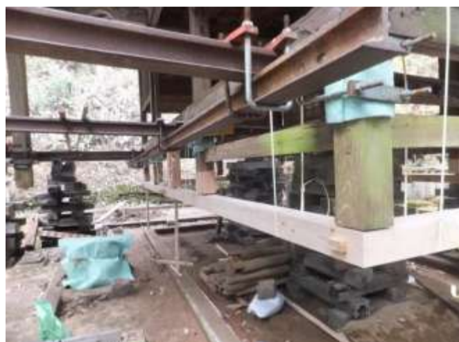
地覆材交換・柱根継 完了
