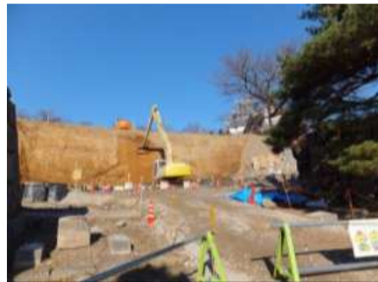
本丸南面法面の調整
