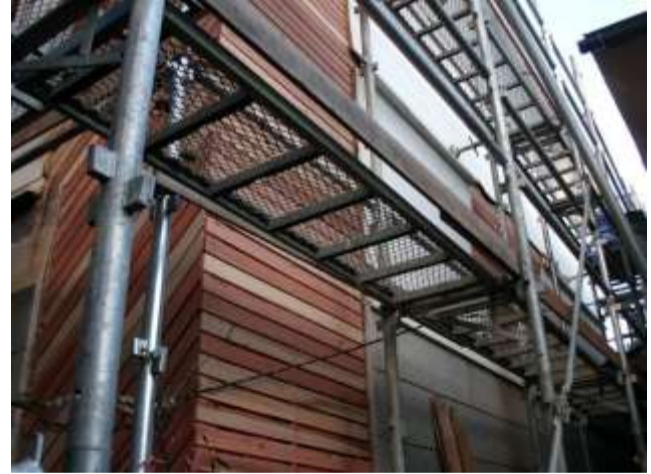
土蔵における新工法施工状況
