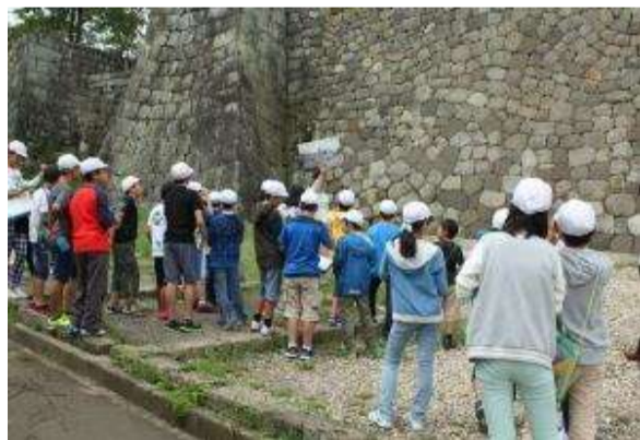
白河の歴史・文化再発見事業 「小峰城跡本丸南面石垣復旧完了状況見学」 (平成27年9月11日 白河第三小学校 6年生)
