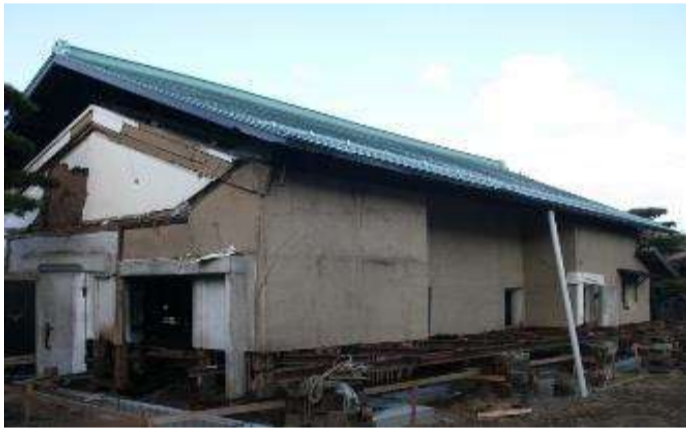
基礎修復中の様子
