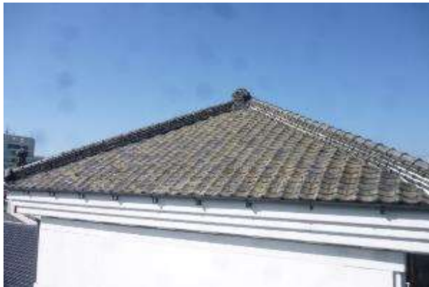
屋根補修(旧商工会議所建造物)
