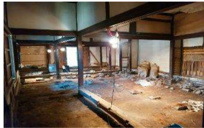
床組解体完了
