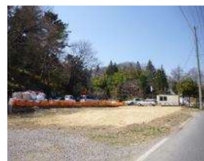
官舎解体完了
