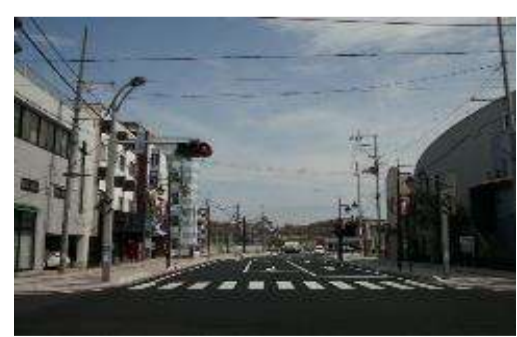
電線共同溝整備完了(左) 抜柱後イメージ(右)
