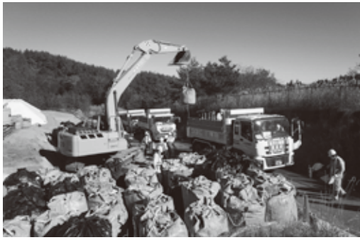
大信地域仮置き場から中間貯蔵施設への試験輸送
