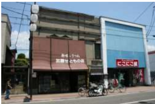
旧脇本陣柳屋旅館・勸工場建物(本町)
