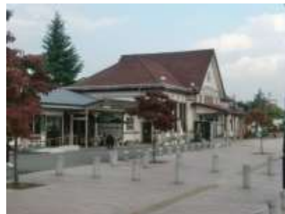
大正建築の白河駅舎(旧三の丸所在)
