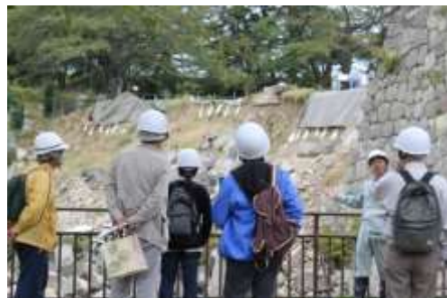
小峰城跡石垣修復箇所一般公開の様子
