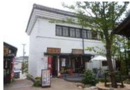
旧商工会議所建造物(中町)
