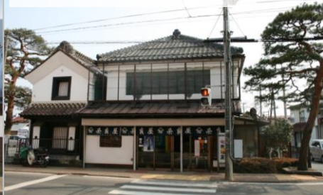
奈良屋呉服店建造物群(一番町)
