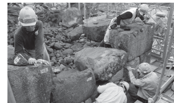
▲石垣の積み上げ作業
