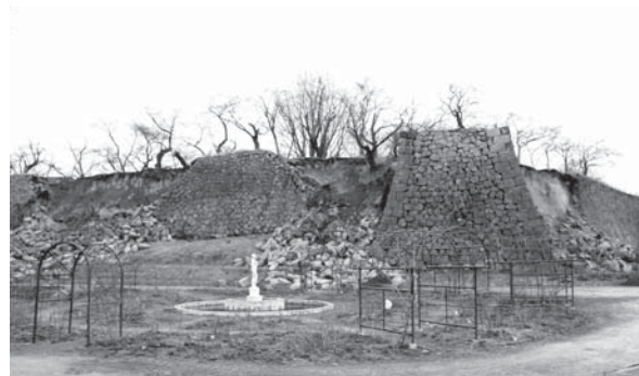
▲崩落した本丸西・北面の石垣
