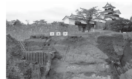
▲石垣解体後の状況
