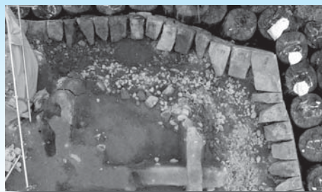
▲解体後の石垣
