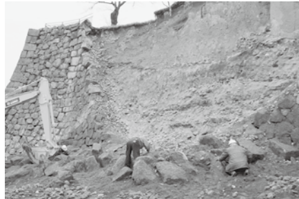
▶埋もれた石材の検出作業(本丸西面)
