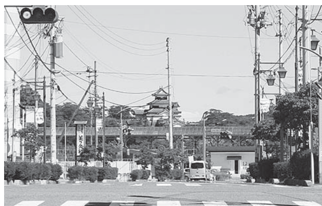
看板の撤去や建物を移転したことで、小峰城三重櫓への眺望を確保することができました。今後、無電柱化も検討していきます。
