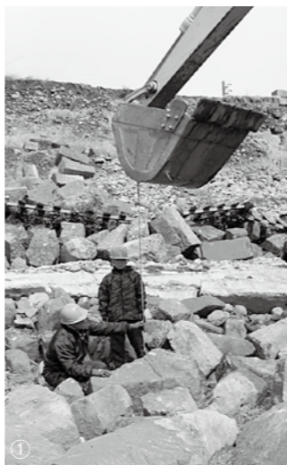
①重機での石材撤去作業 ②石材ごとにカルテを作成 ③高所作業車を使用した石垣背面丘陵部の調査
