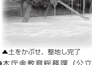
▲土をかぶせ、整地し完了
