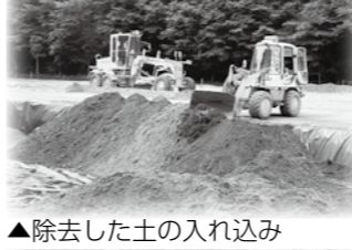
▲除去した土の入れ込み
