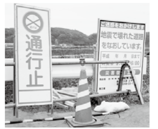
▲災害復旧工事の様子
