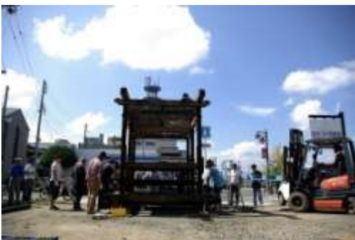
屋台の屋根組み立て準備
