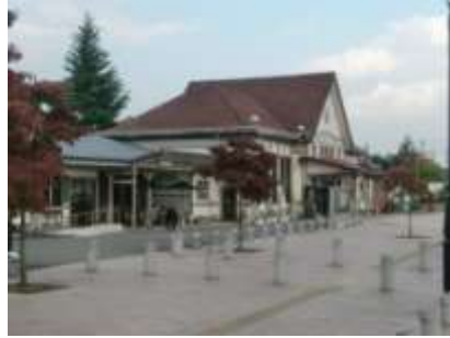
大正建築の白河駅舎(旧三の丸所在)
