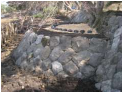
史跡及び名勝南湖公園の護岸整備
