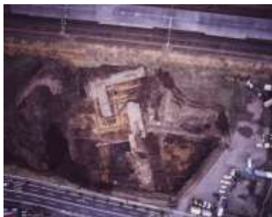
道場門遺構航空写真
