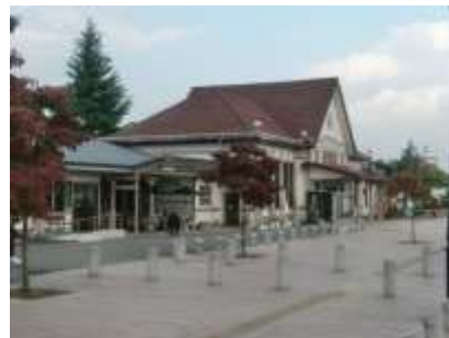
大正建築の白河駅舎(旧三の丸所在)
