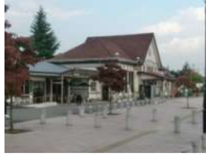
大正建築の白河駅舎(旧三の丸所在)
