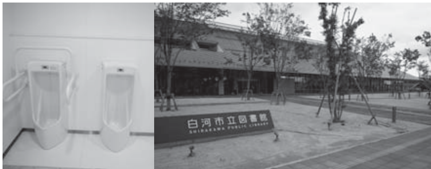
白河市立図書館では、雨水を地下に貯留しトイレの洗浄水として利用している
